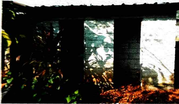
Foto 3: reparación de sanitarios
