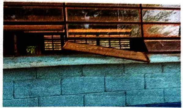
Foto 2: mantenimiento de ventanas y balcones
