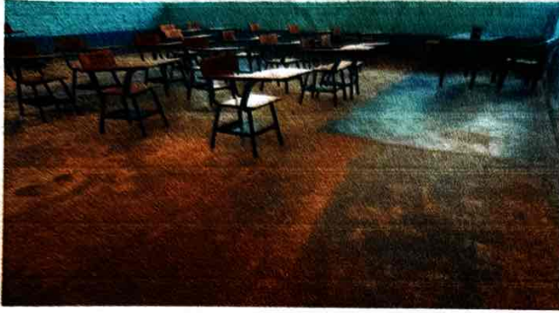
Foto 1: reparación de piso de cemento
